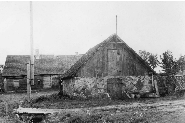
Rūsų Steigvilių kaimo Rudžio sodyboje, statytas XIX a. 1969 m.
