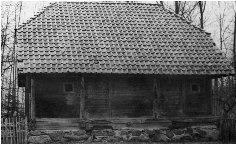
Klėtis Nakrošiūnų kaime, statyta 1881 m. (tašyti rąstai). Klėties planas: 1 – prieklėtis, 2 – klėtis a – didysis „skladas“, b – mažasis „skladas“
